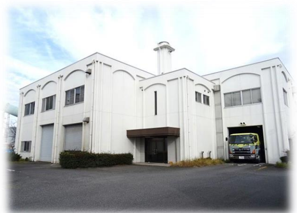
衛生施設（東棟）
